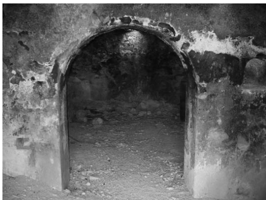
Figura 14.- Interior del Fortín 1 de El Espartal (Valdemoro).
